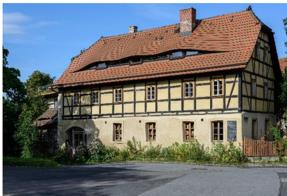
Abb: Typisches denkmalgeschütztes Fachwerkgebäude in Sachsen – nachträglichen Radonschutz individuell anpassen
