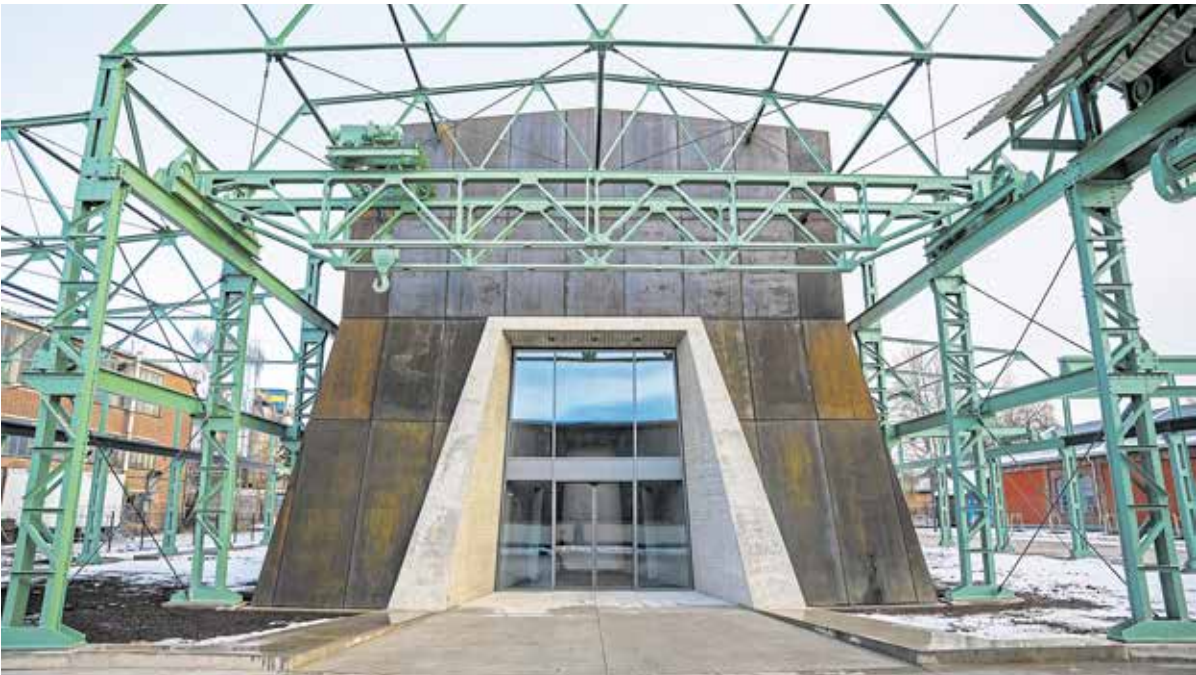
Nach einer Bauzeit von nur 56 Wochen wurde das Kunstwerk in der Halle 18 am 28. November 2025 eröffnet. Foto: Natalie Bleyl
