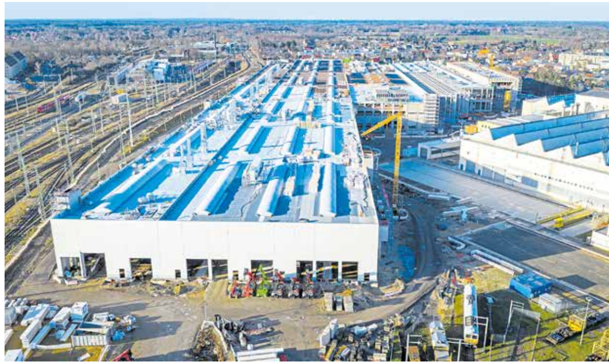
Blick auf das im Bau befindliche ICE-Instandhaltungswerk.
