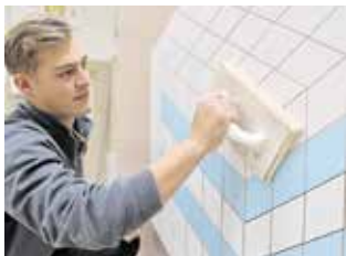
Einen dreidimensionalen Würfel gilt es für die Meisterschüler in der Prüfung zu fliesen.
