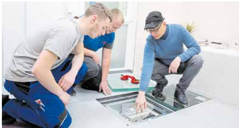
Im E-Haus, dem wohl modernsten Projekt der Handwerkskammer Chemnitz, ist schon heute ein Blick in die Zukunft komplett vernetzter Eigenheime möglich. Foto: Sebastian Paul
