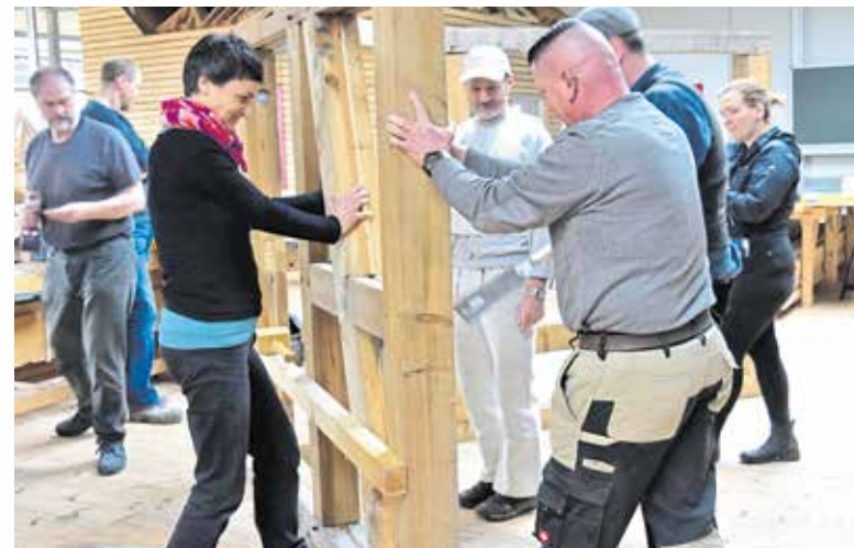
Seminar zur Fachwerksanierung.
